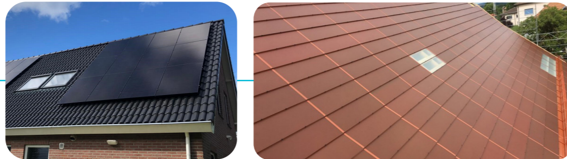
Zonnepanelen in afstemming met dakkleur
