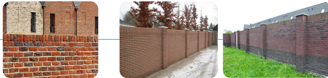
Gemetselde muur met kolommen/poeren en een rollaag
