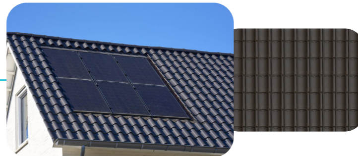
Geïntegreerde zonnepanelen in afstemming met antraciete pannen
