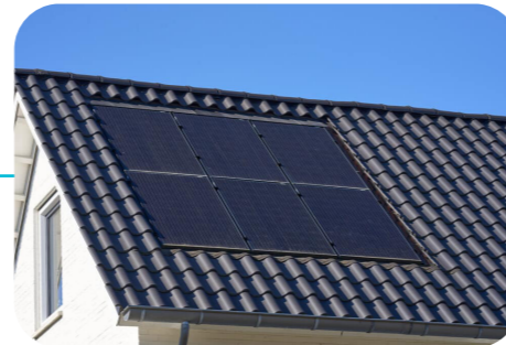
Geïntegreerde zonnepanelen in afstemming met antraciete pannen
